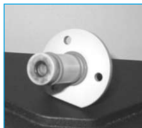
Dégradation UV du PEEK
